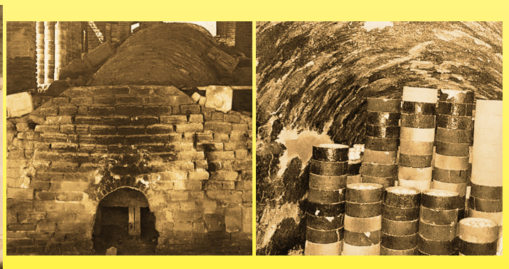
Dragón chino tradicional horno (龙窑 Long Yao). Boca de alimentación y procedimiento de llenado de porcelana eléctrica (colección privada)
