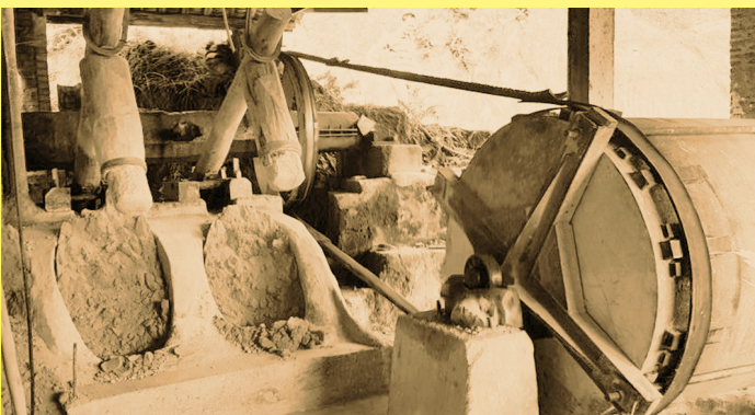
Máquinas tradicionales ((水碓 shui duì)) para la producción de los polvos utilizados en la fabricación de la porcelana eléctrica (colección privada)
